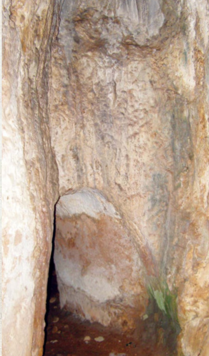
Άποψη από το εσωτερικό της σήραγγας στον Κοκκινόπηλο The tunnel's interior at Kokkinopilos
