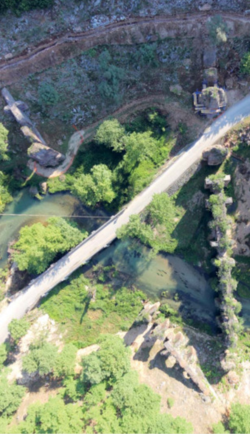
Άποψη πεσσσοτοιχιών ρωμαϊκού υδραγωγείου στην περιοχή Αγίου Γεωργίου The arcades at Aghios Georgios
