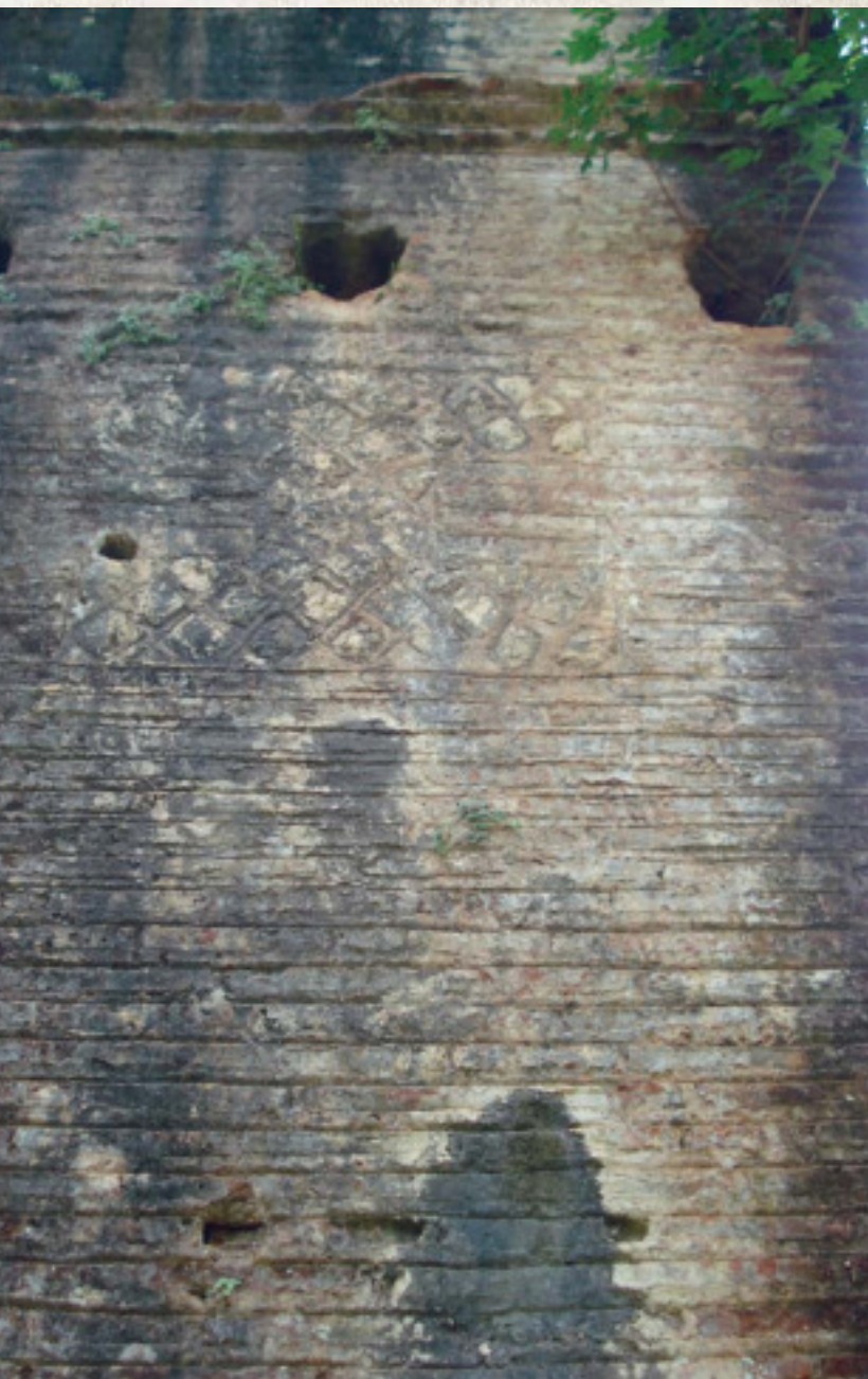
Οπές για την τοποθέτηση ελκυστήρων / Put - log holes
