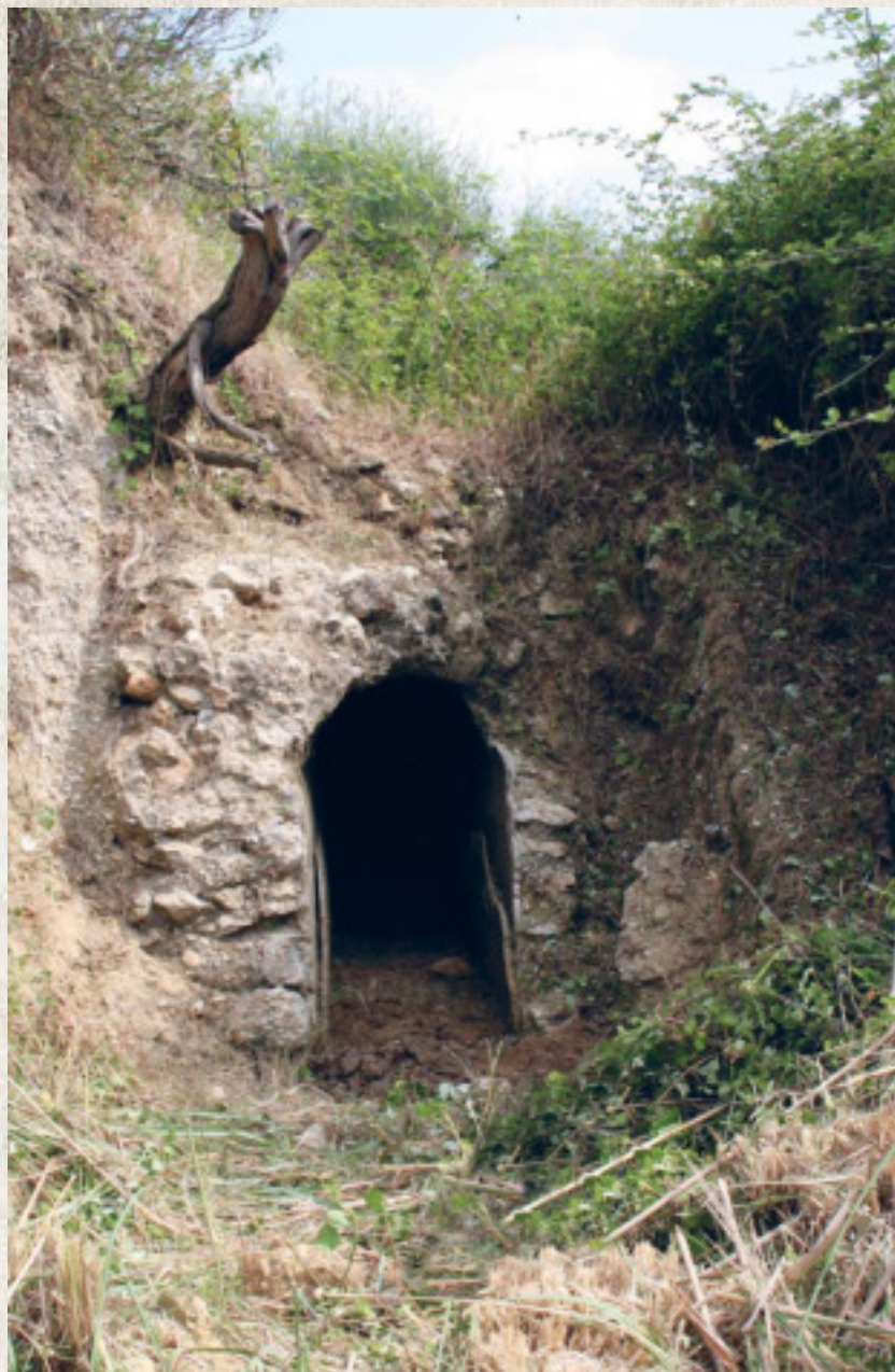
Άποψη τμήματος του αγωγού στην περιοχή της Παλαιομάνας Section of the conduit at Palaiomana
