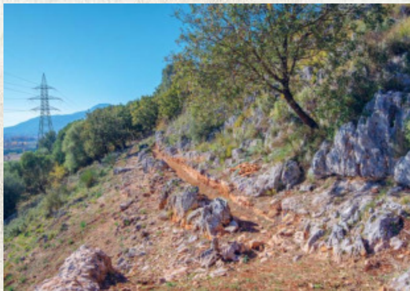
Άποψη του υδραγωγείου στη Στεφάνη, όπου διακρίνονται τα κατάλοιπα δεύτερου αγωγού σε παράλληλη πορεία με τον πρώτο / The aqueduct at Stefani where a second conduit in parallel course with the first is visible
