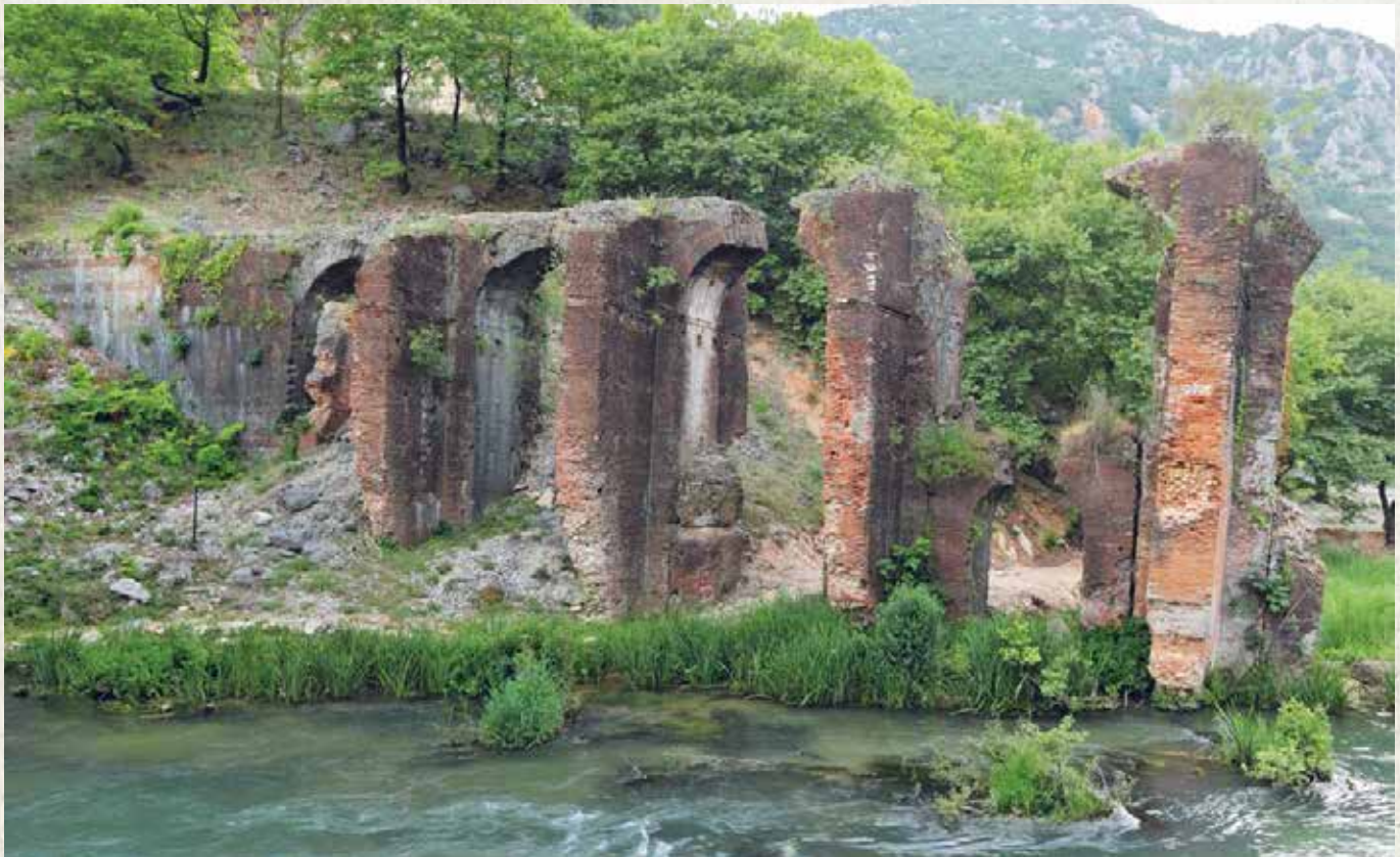
Άποψη της βόρειας πεσσοστοιχίας του ρωμαϊκού υδραγωγείου στην περιοχή του Αγίου Γεωργίου / Section of the northern arcade at Aghios Georgios
