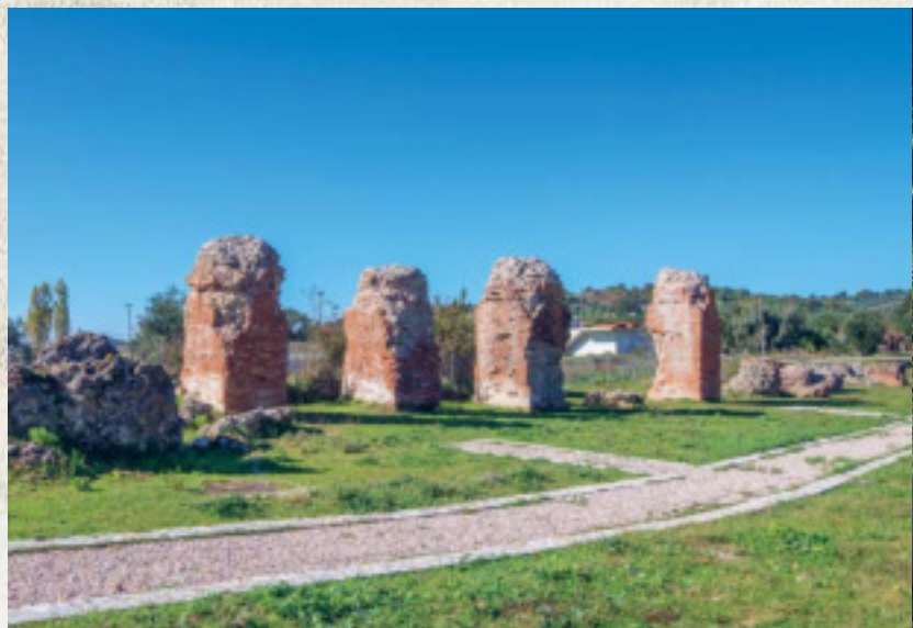
Άποψη της πεσσοστοιχίας στην περιοχή Ηρώου Αρχαγγέλου The arcade at Heroon, Archangelos
