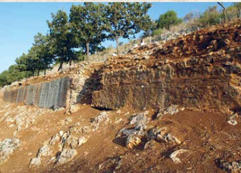
Άποψη του αναλημματικού τοίχου στη Στεφάνη, όπου διακρίνονται οι διαφορετικές τεχνικές δόμησης / The retaining wall at Stefani where two different building techniques are visible
