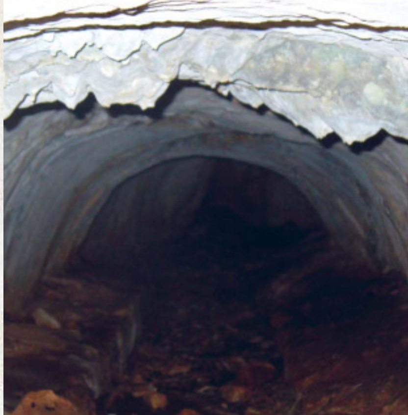
Άποψη από το εσωτερικό της σήραγγας στη Στεφάνη The tunnel's interior at Stefani
