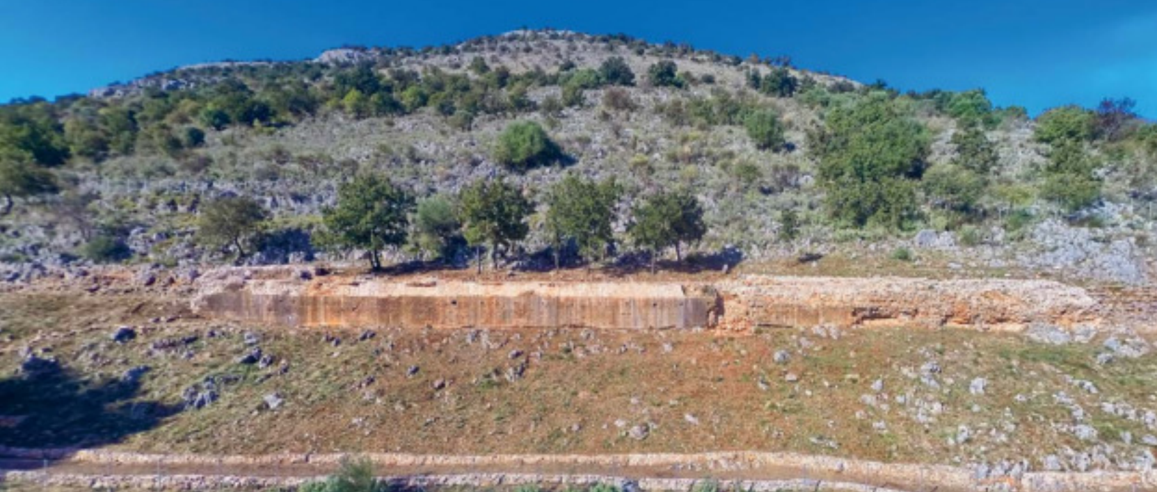
Άποψη του αναλημματικού τοίχου στη Στεφάνη / The retaining wall at Stefani
